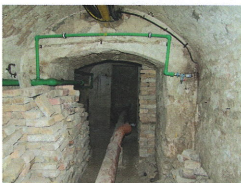
helyreállítatlan faláttörés, építési törmelék
