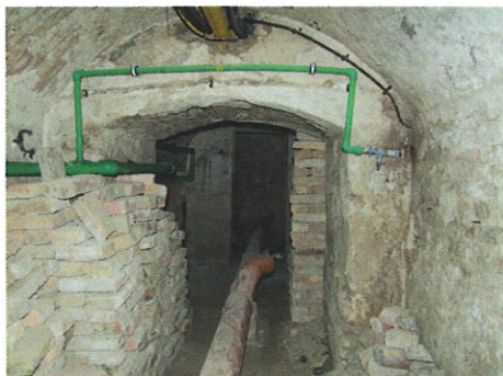
a pincetérben húzódó ép. gép vezetékek az épület gázvezetékének bekötése és az épület hidegvízvezeték mérőórája ( alaprajz 3., 4., 6., 7. raktár )
