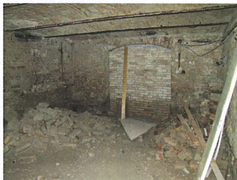
helyreállítatlan faláttörés, építési törmelék
