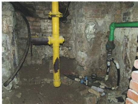
a pincetérben húzódó ép. gép vezetékek az épület gázvezetékének bekötése és az épület hidegvízvezeték mérőórája ( alaprajz 3., 4., 6., 7. raktár )
