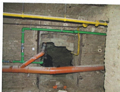
az épület hidegvízvezeték, földgázvezeték és szennyvízlefolyó vezetékai ( alaprajz 3., 4., 6., 7. raktár )
